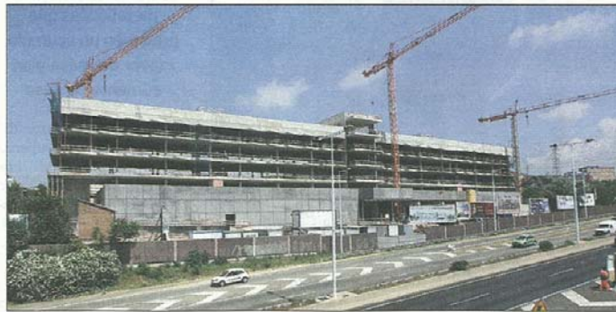
Aspecto del estado actual de las obras de la nueva clínica de Fiatc en Barcelona.
